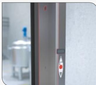
**Capots inversés** à l'intérieur des montants pour faciliter l'accès à l'armoire intégrée
